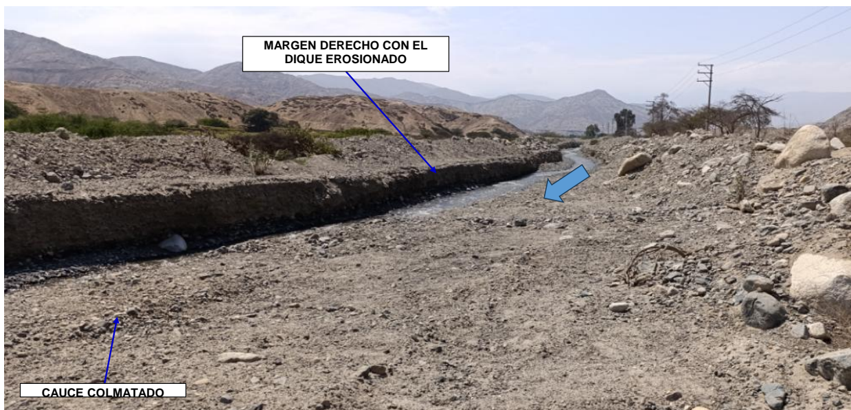
FIGURA N°02: TRAMO CRÍTICO EN LA QUEBRADA PISQUILLO ORCÓN, CON DIQUES EROSIONADOS EN AMBOS LADOS DEL CAUCE, A SU VEZ EL CAUCE SE ENCUENTRA COLMATADO DE SEDIMENTO.
