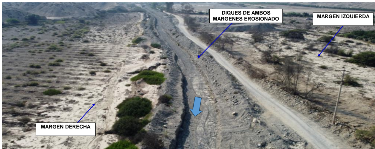
FIGURA N°01: QUEBRADA PISQUILLO ORCÓN, CUYOS DIQUES EN AMBOS LADOS DEL CAUCE SE ENCUENTRA EN ESTADO DE EROSION AVANZADA, CON DESBORDE HACIA AMBOS LADOS, CAUCE COLMATADO Y A LA MARGEN IZQUIERDA DE RIO TROCHA CARROZABLE
