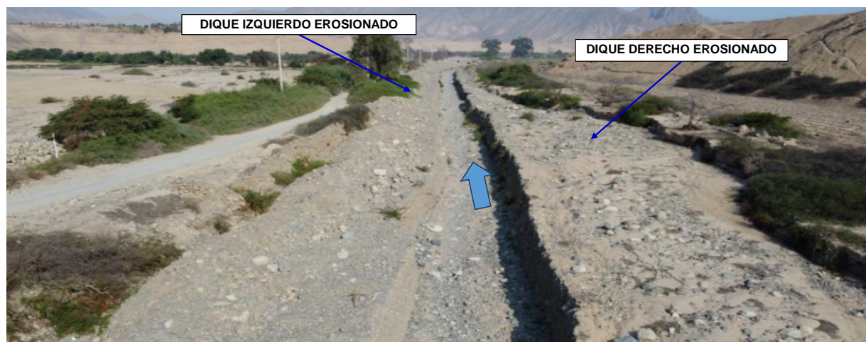
FIGURA N°04: TRAMO DE RIO CON LOS DIQUES DE AMBOS LADOS EN ESTADO DE EROSION AVANZADA EN ALGUNOS TRAMOS NO HAY DIQUE A CAUSA DE EROSIÓN Y EL CAUSE COLMATADO DE FLUJO DE DETRITOS.
